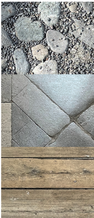
Historisch wertvolle Böden, Täfer und andere Bauteile werden gesichert und wo möglich in den Umbau integriert.
